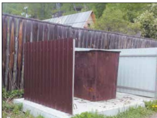
Новые площадки под мусор
